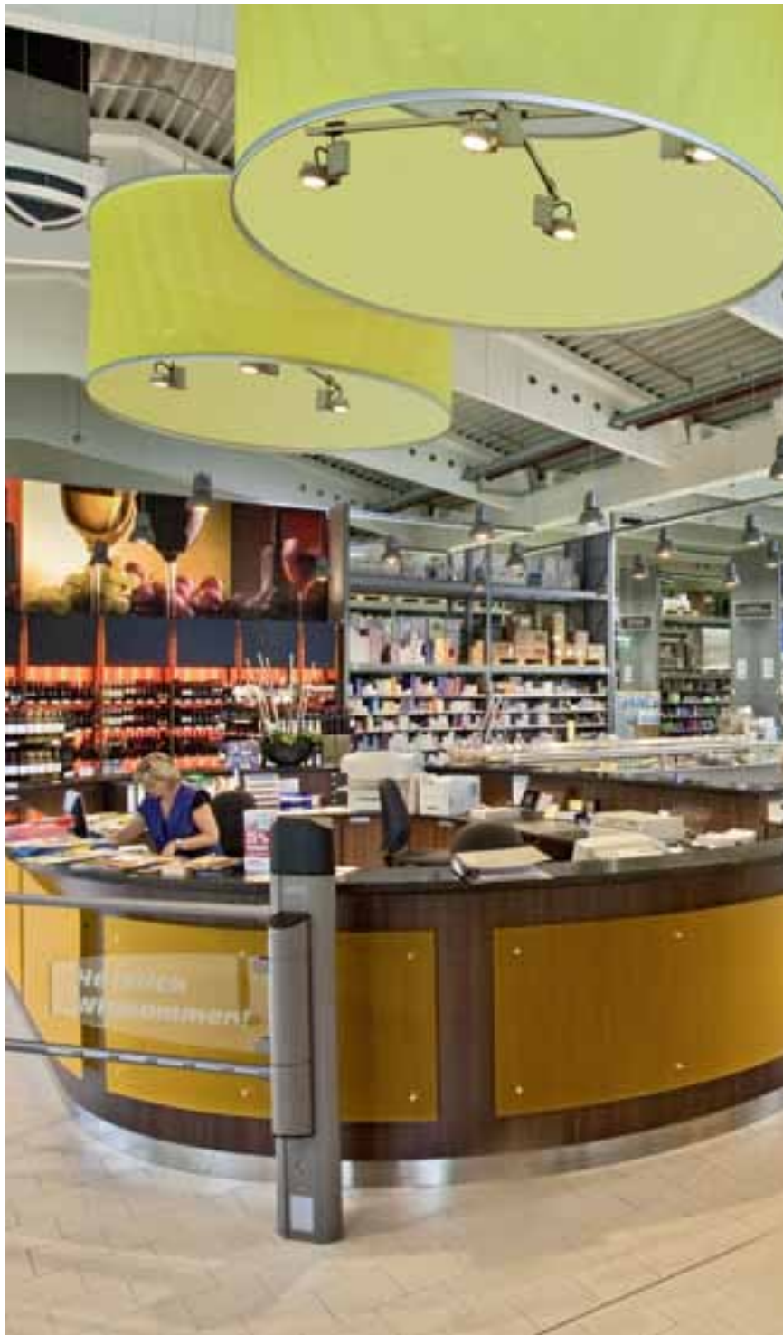
Aufbauleuchten an Stromschiene dienen hier als Ausleuchtung für den auffälligen, überdimensional großen Leuchtschirm.
